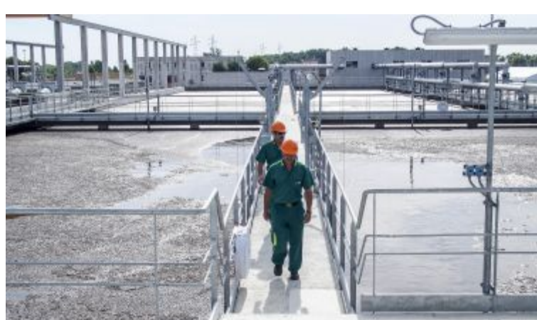
Il depuratore di Santa Giustina
